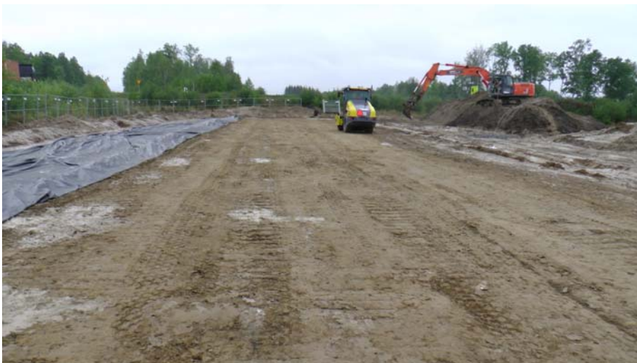
Figur 6. Terrass efter packning.
