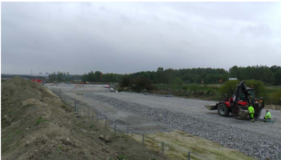
Figur 9. Färdiga provytor. I förgrunden, plattbelastningsförsök på yta C21 (100 cm).
